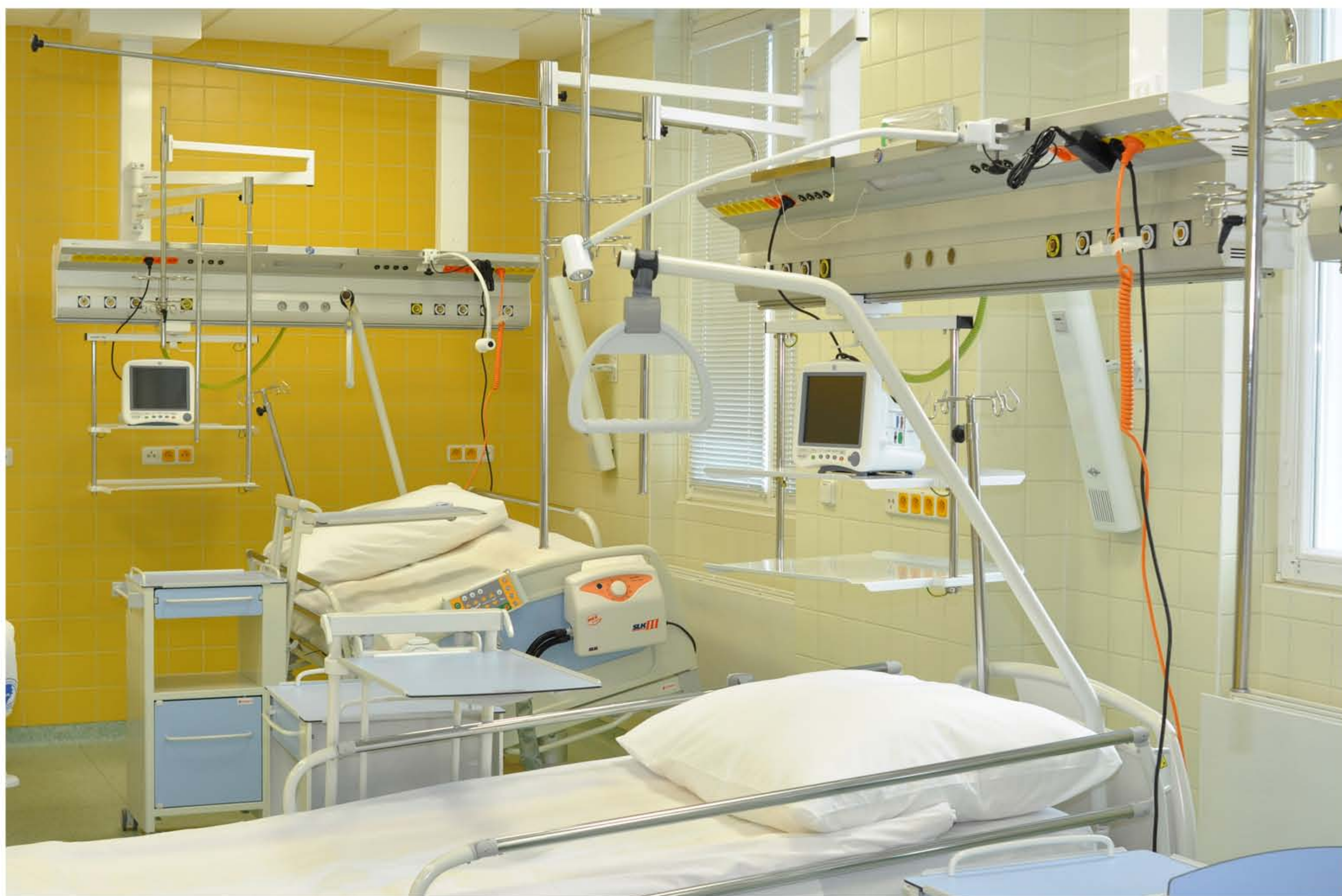
Рисунок 2.1- Модуль газопостачання мостовий стельовий ZMP07 MZ Liberec a.s.
